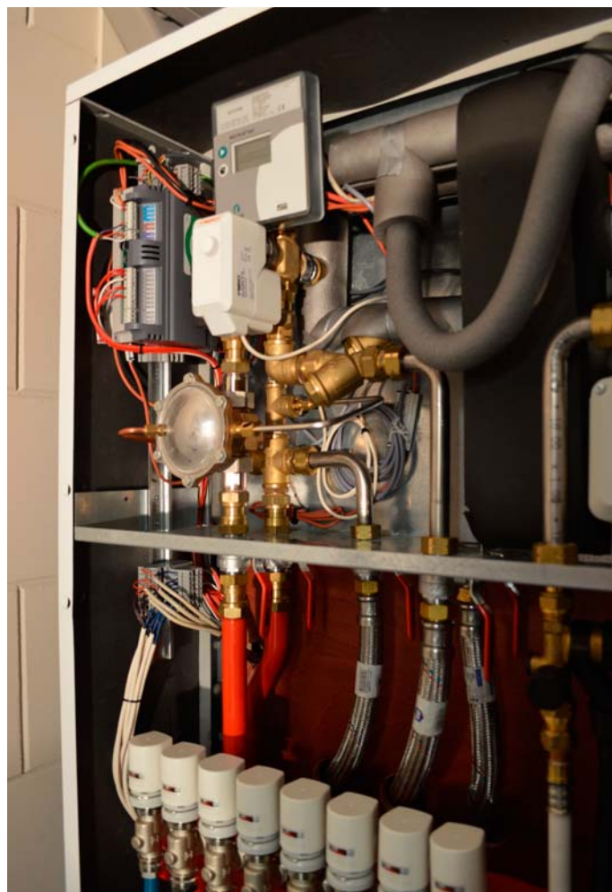
DRIES in de woning: installateursdeel
