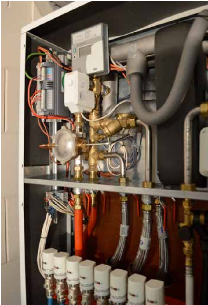
DRIES in de woning: installateursdeel
